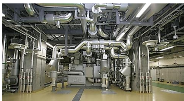
ヒートポンプチャラー（熱回収型）
